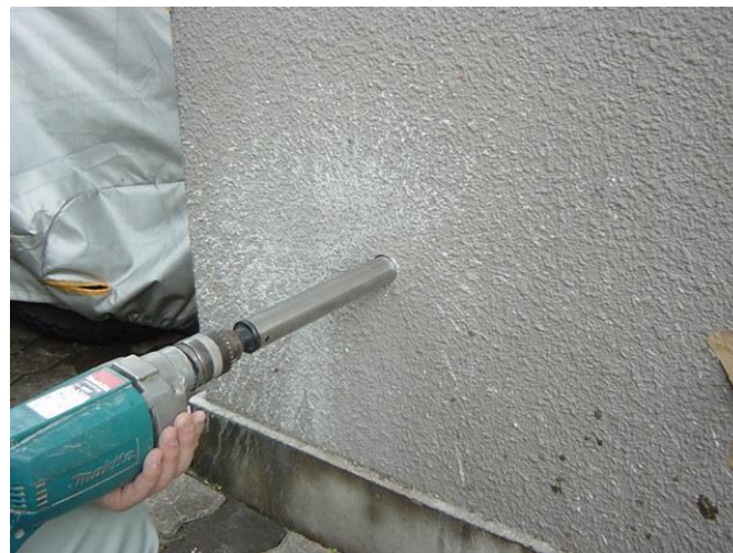
中性化測定測定
