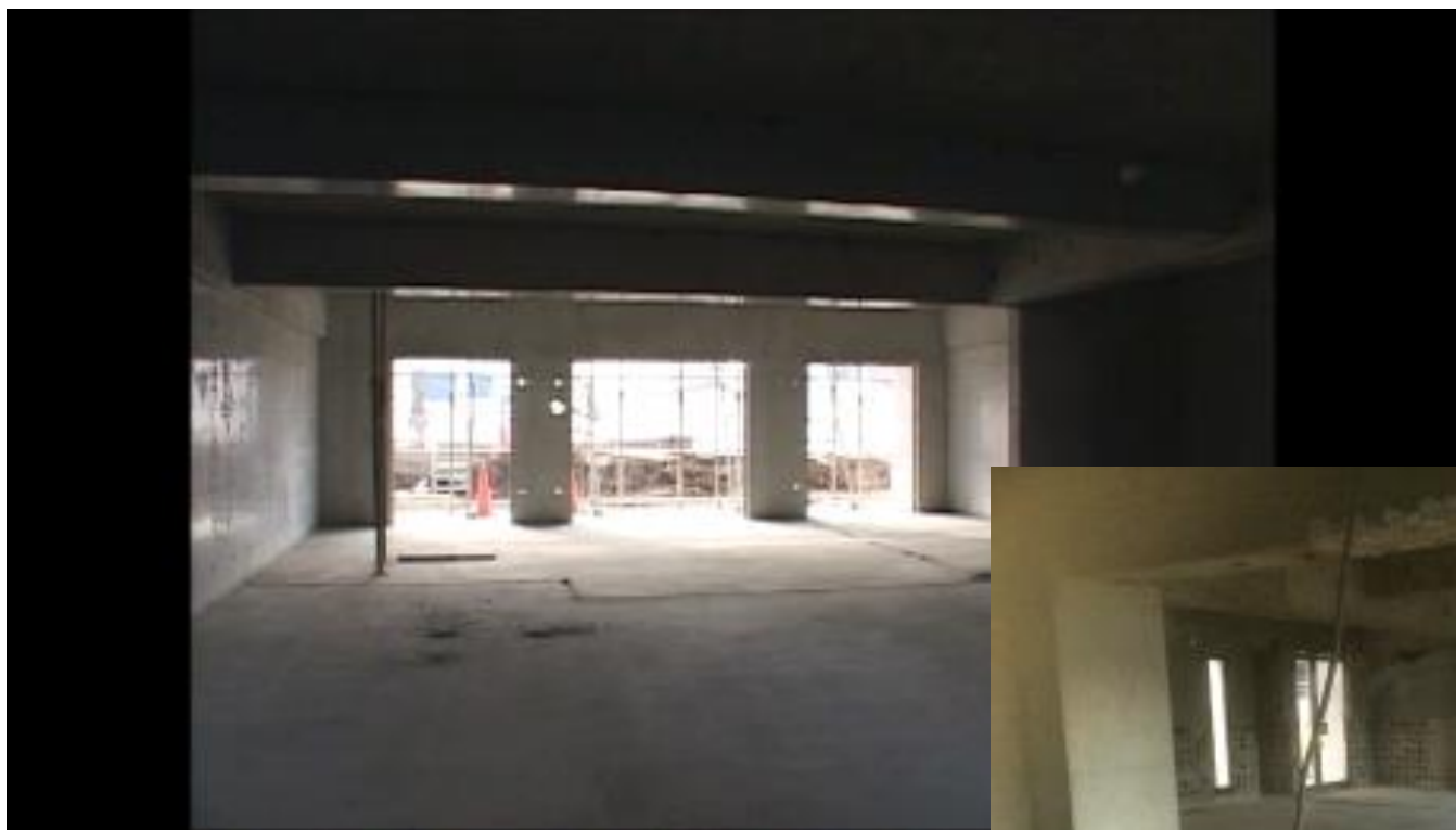
新築の躯体が打ち上がった状態
