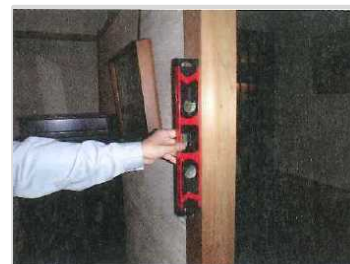
水平器による柱の傾きの計測
