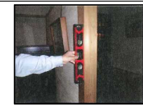
水平器による柱の傾きの計測
