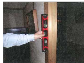
水平器による柱の傾きの計測
