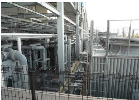
下水再生水熱利用システム
