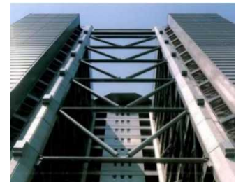
図・写真—東館制振ブレース 桁行き方向の補強と梁間方向の補強
