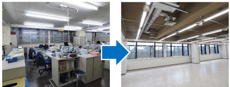
写真一執務室の直天井化（左：改修前、右：改修後）
