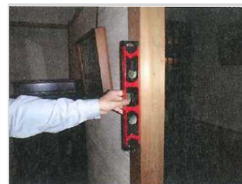
水平器による柱の傾きの計測
