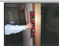
水平器による柱の傾きの計測
