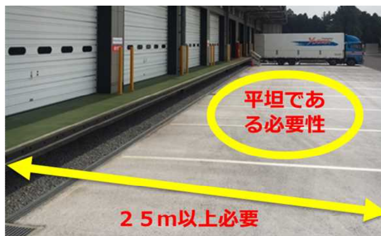
【図１－７：バースの接着幅のクリアランス】
