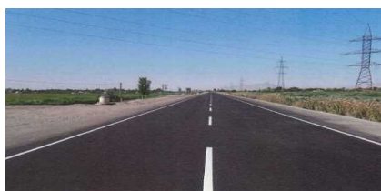
クルガンチューベ・ドゥスティ間道路 改修計画Ⅰ期・Ⅱ期
