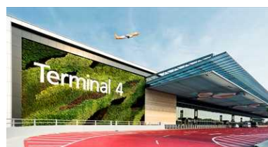
シンガポールチャンギ国際空港 第4ターミナル新築工事
