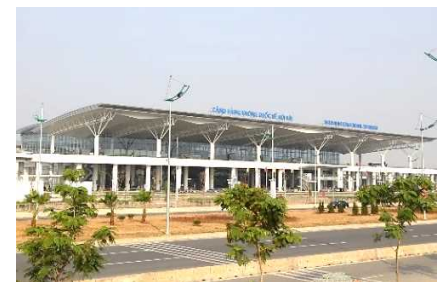
ノイバイ国際空港 第2旅客ターミナルビル新築工事
