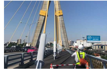
足場設置不要の高所ひび割れ計測 クモノスコーポレーション(株)
