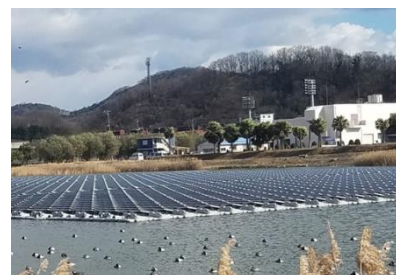
「かさおか十一番町遊水池 水上ソーラー発電所」の景観（自然エネルギー財団HPより）
