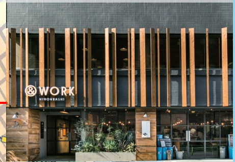
&WORK NIPONBASHI (クリエイティブオフィス、クラフトビールバー)
