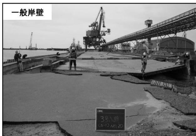
東日本大震災における耐震強化岸壁と一般岸壁の被災状況（小名浜港の例）
