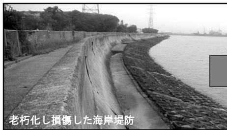
老朽化し損傷した海岸堤防
