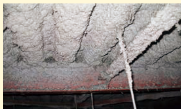
事務室の天井裏
