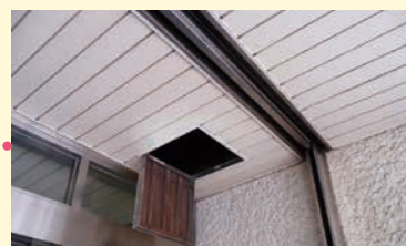
玄関横シャッター周り
