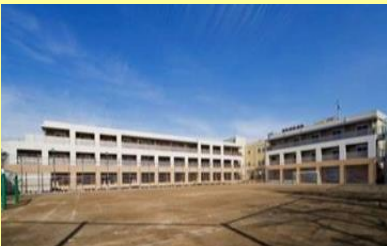
学校を改修して整備した事例
