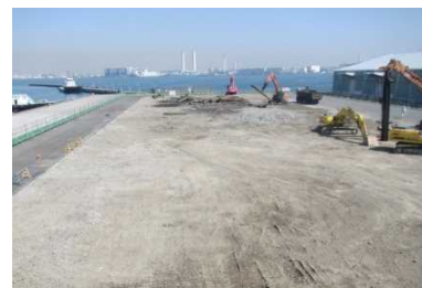
上屋の解体状況 (H30.3撮影)
