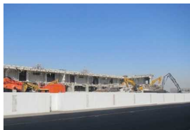
上屋の解体状況 (H30.3撮影)
