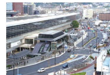
京都駅八条口整備後
