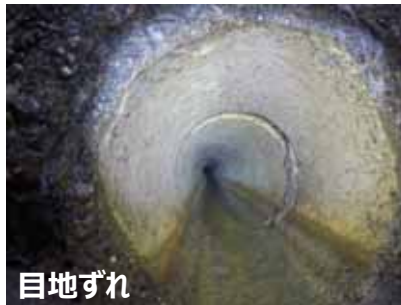
図 管口カメラによる調査画像
