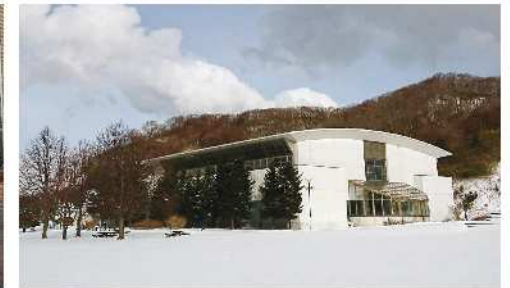
家庭用燃料電池が整備された市営温水プール
