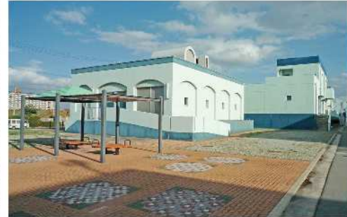
三宝水再生センターの送水施設
