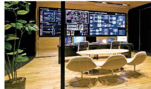
エネルギー管理システム
