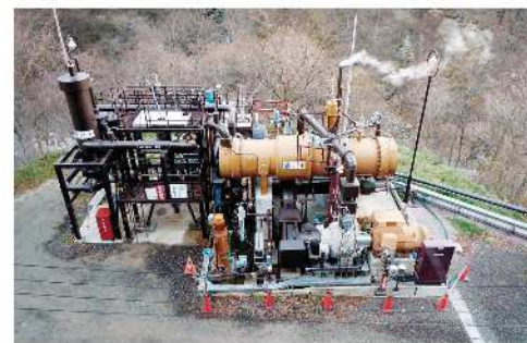
まちづくりの柱としてスタートしたバイナリー発電設備
