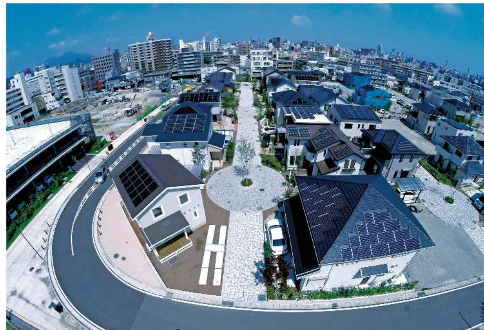
住宅に太陽光発電設備や家庭用コージェネレーションシステムなどを設置
