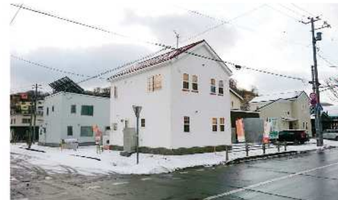
各戸に家庭用燃料電池を整備した街区
