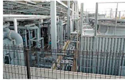
下水再生水熱利用システム
