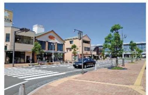
駅前広場の整備により、周辺民間開発(集合住宅を含む)を誘発
