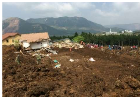
被災状況(高野台地区)
