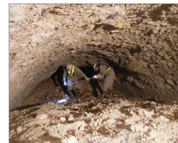
落盤が進んだ壕内の状況
