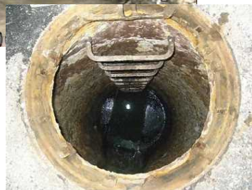
コンクリートが腐食し、鉄筋が露出した管路施設
