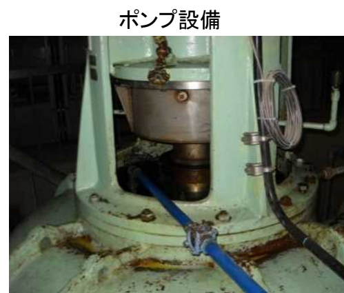
ポンプ本体(内部軸受)の劣化
