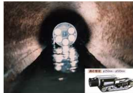
・テレビカメラによる点検・調査
