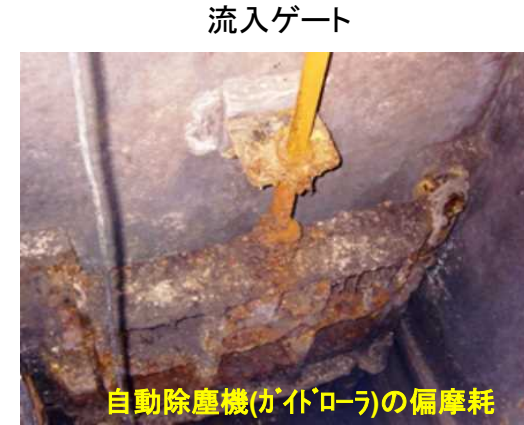
腐食が進行し開閉に支障
