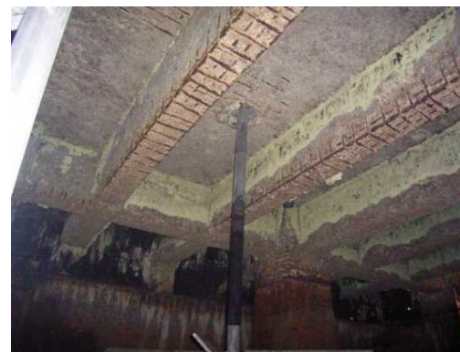
腐食が進行し鉄筋露出
