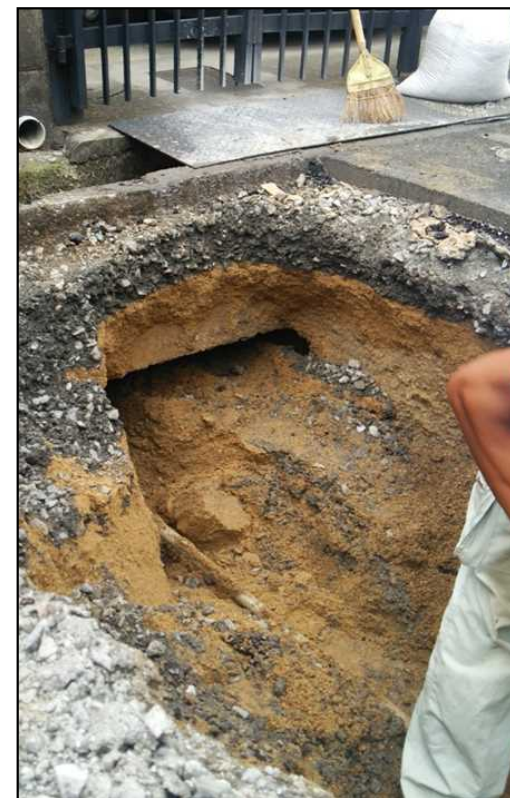
【舗装撤去状況 (空洞箇所)】
