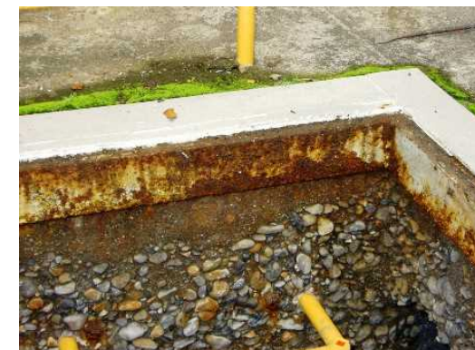
硫化水素により骨材露出
