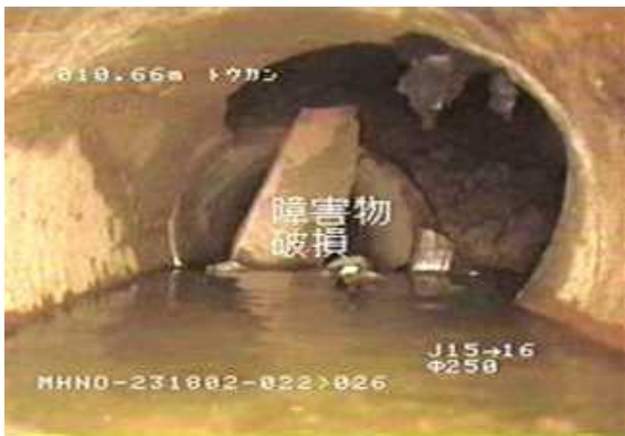
破損した管路
