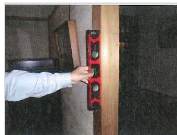
水平器による柱の傾きの計測
