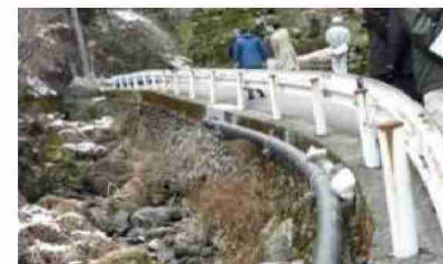
クイック配管(露出配管)
