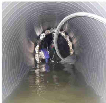
管更生による管渠の耐震対策
