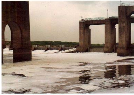
1968年(昭和43年) 田園調布堰の発泡 国土交通省京浜河川事務所提供
