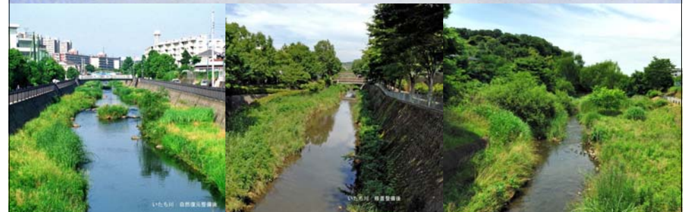
いたち川橋～海里橋
