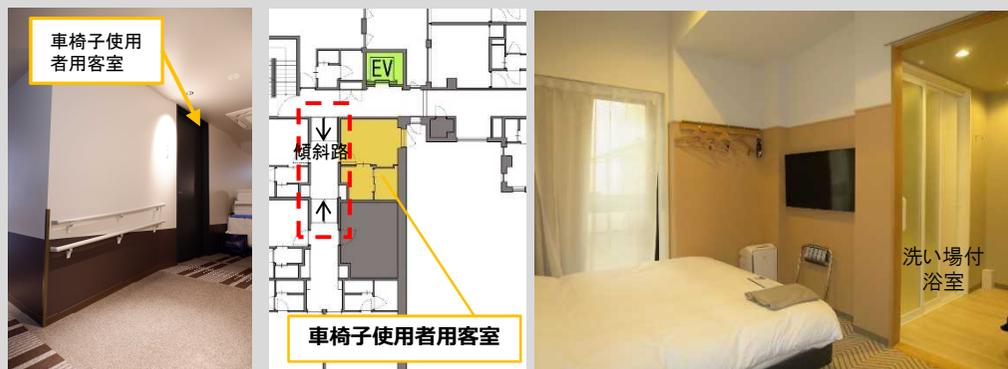
共用廊下のスロープ設置により段差解消（車椅子利用者用客室内のフラット化）
