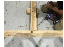
※土台・柱接合部の補強(引抜)
