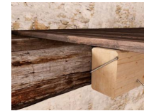
※現場施工例(梁の補強)
