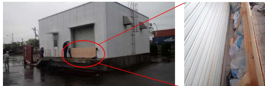
合板や土のう等による電気設備への止水板の設置事例
