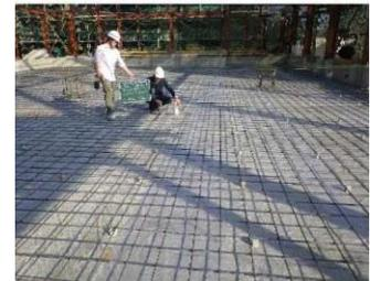
床下は土が露出していたが、湿気対策として土間コンクリートを敷設し、床下換気口を充実させた。
