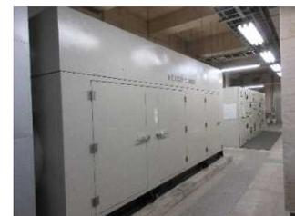
写真－別館に設置されているバックアップ電源
