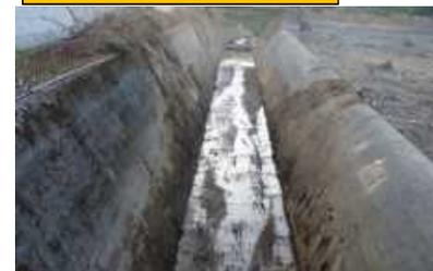
緊急応急工事により厚真ダム余水吐に堆積した土砂等を撤去(2018.9.29完了)
