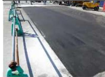
液状化による沈下で、コンテナヤードに段差が生じ、荷役に支障となったため、仮舗装を施工し段差を解消。
