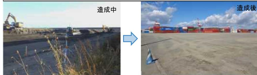
コンテナヤードが被災したため、本復旧までの間、荷役・物流に影響を及ぼさないよう、仮設のコンテナヤードを造成。
