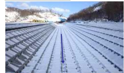
河道閉塞箇所からの流水を安全に流下させるため水路工(ブロック張り)を整備
