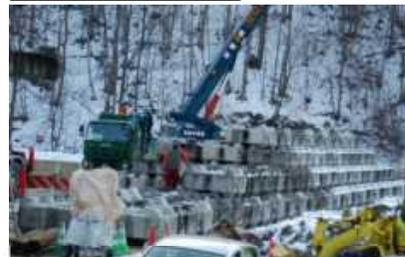
不安定土砂流出防止のためブロック砂防堰堤工を整備
