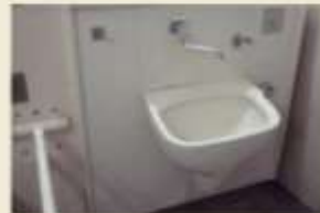
車いす対応トイレ
