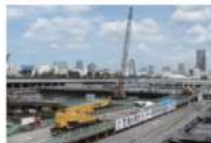
施工状況(平成24年8月)
