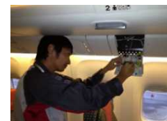
客室内の照明の交換
