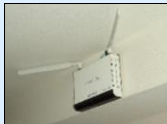
無料公衆無線LAN環境の整備
