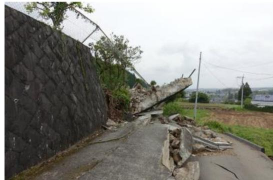
写真 3.3-11 崩壊した擁壁
