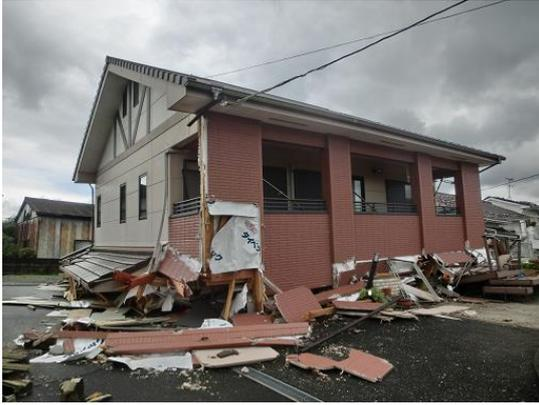
写真 3.3-6 倒壊した木造住宅
