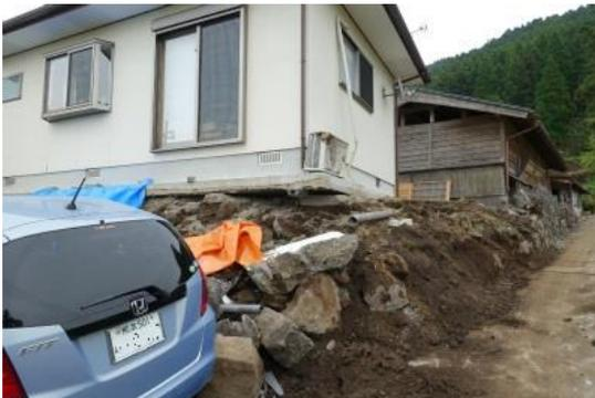
写真 3.3-10 崩壊した擁壁
