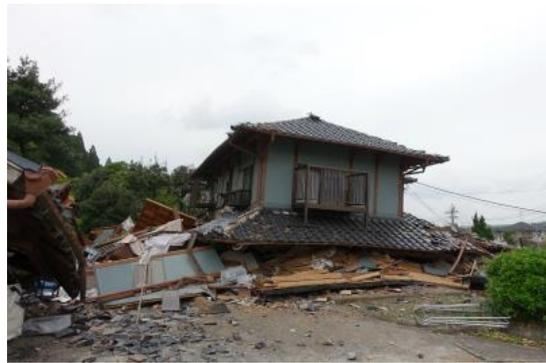
写真 3.3-9 倒壊した木造住宅
