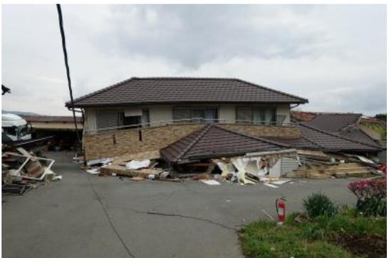
写真 3.3-16 倒壊した木造住宅
