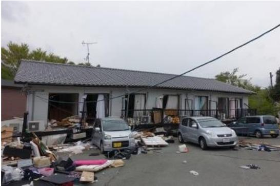
写真 3.3-12 倒壊した木造アパート
