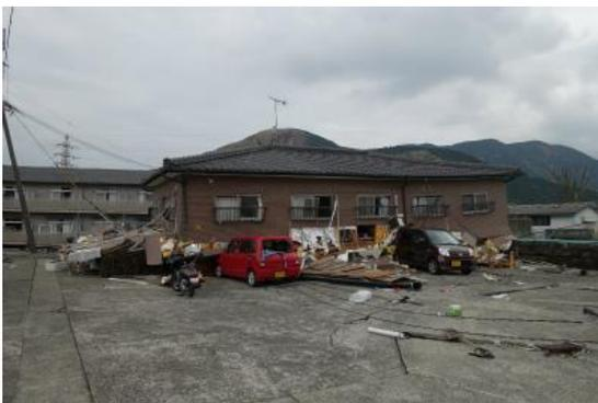
写真 3.3-14 倒壊した木造アパート
