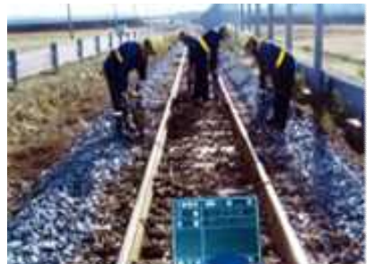
レールの修繕
