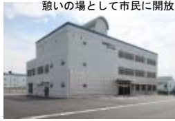
地域の一時避難施設としても活用する災害対策センター（処理場内に設置）
