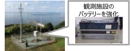
観測施設のバッテリーを強化 災害時でも確実に気象観測を継続するための電源強化
