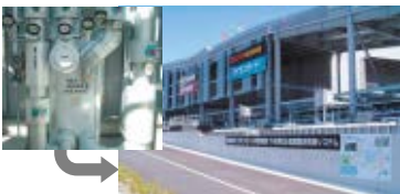
処理場の熱を近隣の大型商業施設へ供給
