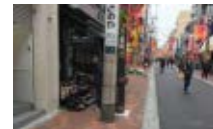
道路事業において、電柱が歩道上に残った事例
