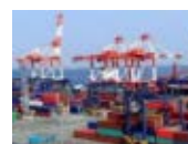
コンテナターミナルにおける浸水対策
