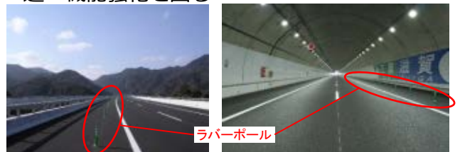
現況写真(構造物6車線対応区間)
