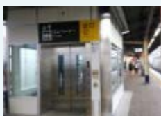
鉄道駅におけるエレベーターの設置
