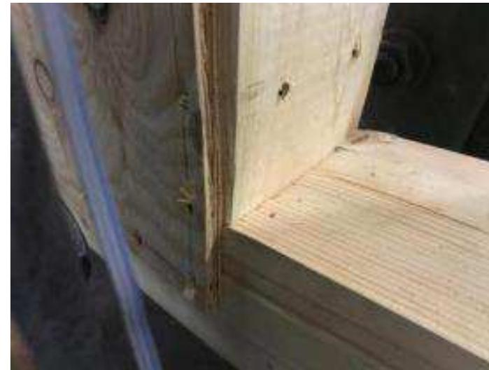
写真5.3-5 たて枠の下枠へのめり込み
