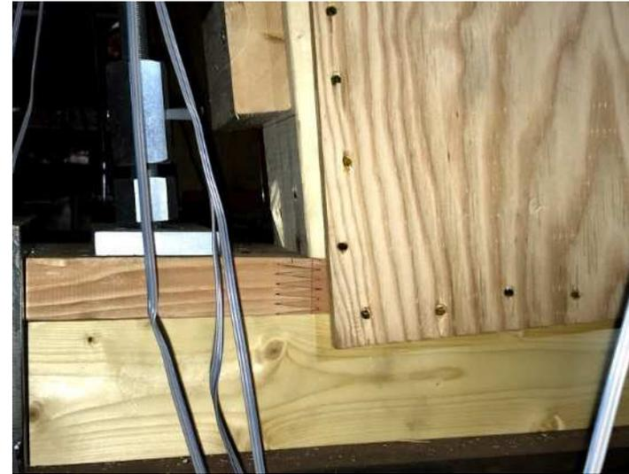
写真5.4-6 たて枠の下枠へのめり込み
