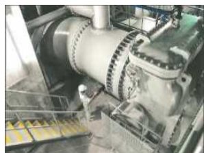
雨水ポンプ(広島市)
