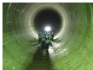
雨水貯留管(東京都)
