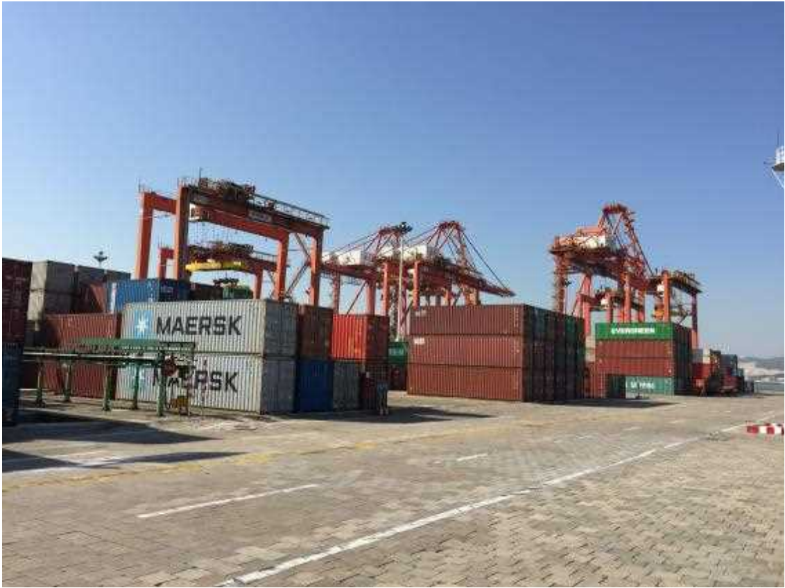
写真 参考-5 コンテナターミナル内
