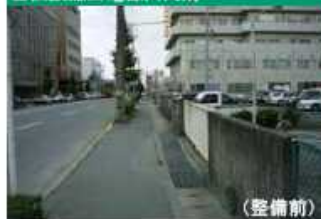
■松阪鎌田電線共同溝
