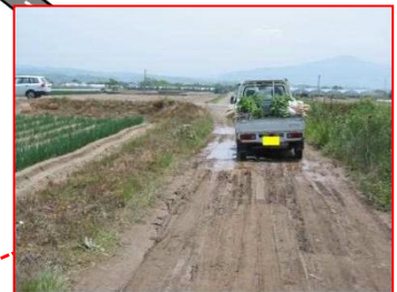
ほ場内農道は未舗装で凹凸が大きい
