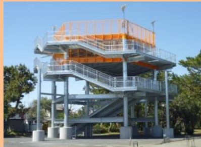
津波避難タワー等の避難施設
