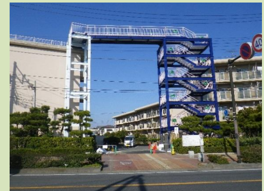
既存施設(市営住宅)へ避難階段設置【藤沢市】 その他、民間施設への補助事例あり (屋上部避難場所設置)
