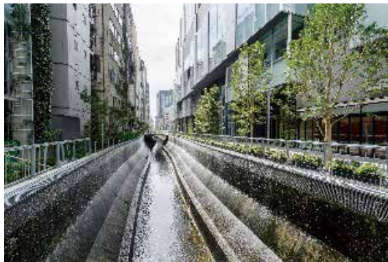
図表1-1-11 渋谷川 清流復活水を活用した壁泉の様子
