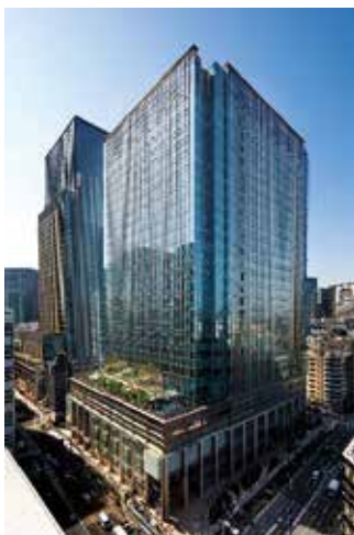
図表1-2-8 日本橋自立・分散型エネルギー供給施設
