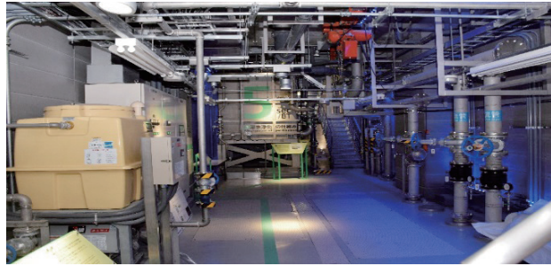
図表1-2-10 大手門タワー・JXビルと濠水の大型貯留槽・高速浄化施設
