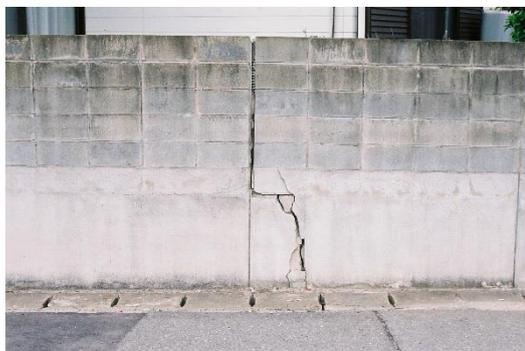
塀に大きなひび割れが生じている
