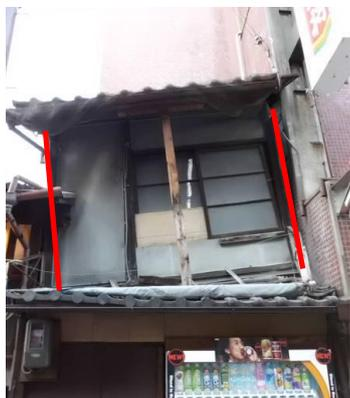
2階部分が沈み込み全体的に傾斜している
