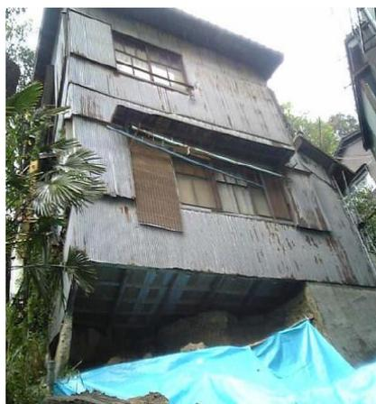
基礎が大きく欠損している
