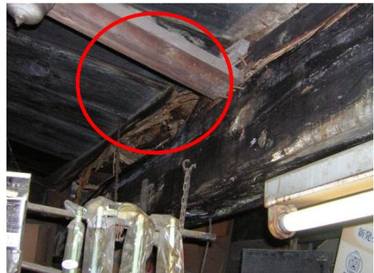
はりの破損、腐食などが発生している
