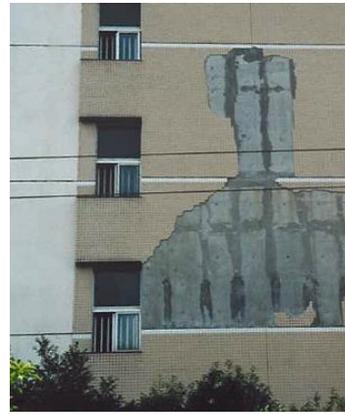
外壁に脱落が生じている
