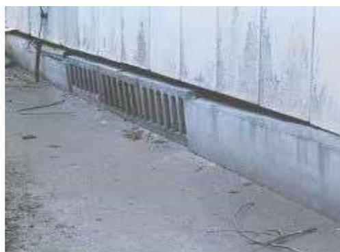
基礎が沈下し破損している
