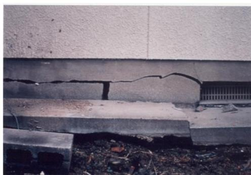
基礎が大きく破損している
