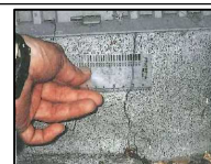
基礎のひび割れ幅の計測
