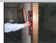
水平器による柱の傾きの計測
