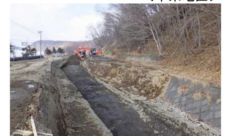
農業水利施設の復旧
