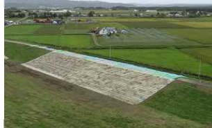
緊急復旧工事完了【9月13日】
