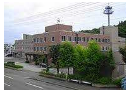
重要インフラの緊急点検(官庁施設)
