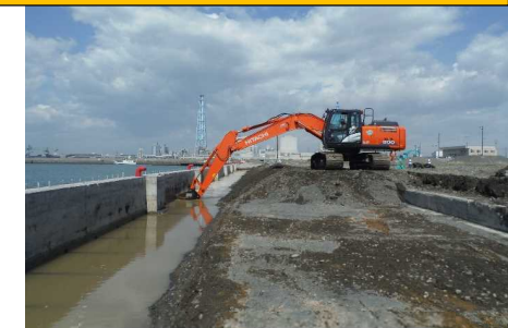
東港区物揚場(-4m) 裏埋土撤去
