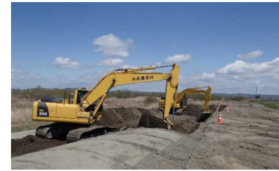
クラック調査に基づき丁張りを設置し切り返し工を実施。
