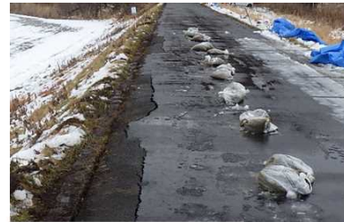
準備工(シート撤去)の実施
