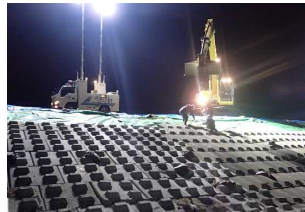
緊急復旧工事状況【9月10日】
