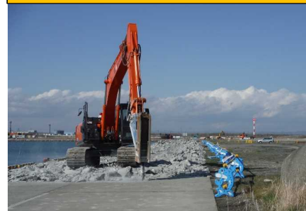
東港区物揚場(-4m) エプロン撤去
