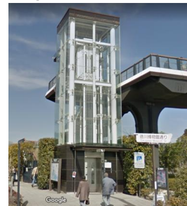
梅桜橋エレベーター（茨城県水戸市） 水戸偕楽園へ向かう歩道橋に設置
