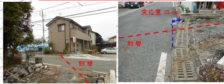
最大の約35cmの右ズレが確認された亀裂
